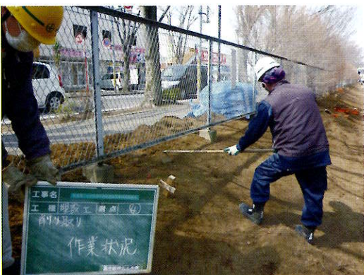
2丁目バス通りの地金堀側の除染作業 柏市役所提供 表土を削るなどの作業が行われた
