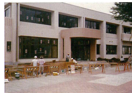
建設中の近隣センター(昭和61年)
