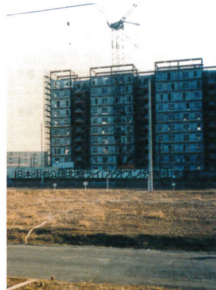
建設が進む高層住宅
