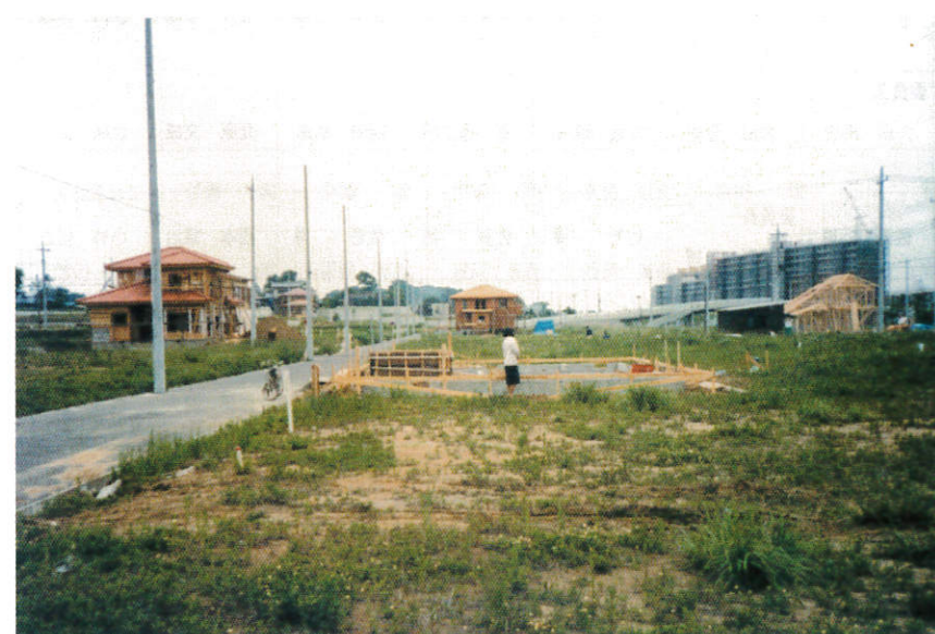
6丁目の戸建住宅の建設始まる
